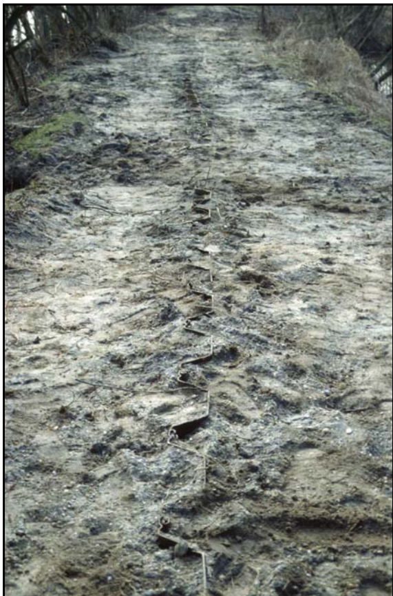
Abb. 5. Spundwandsicherung an einem Deich der Ilm (Landkreis Pfaffenhofen).
