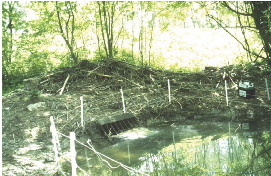
Abb. 7. Sicherung eines Durchlasses mit Elektrozaun
