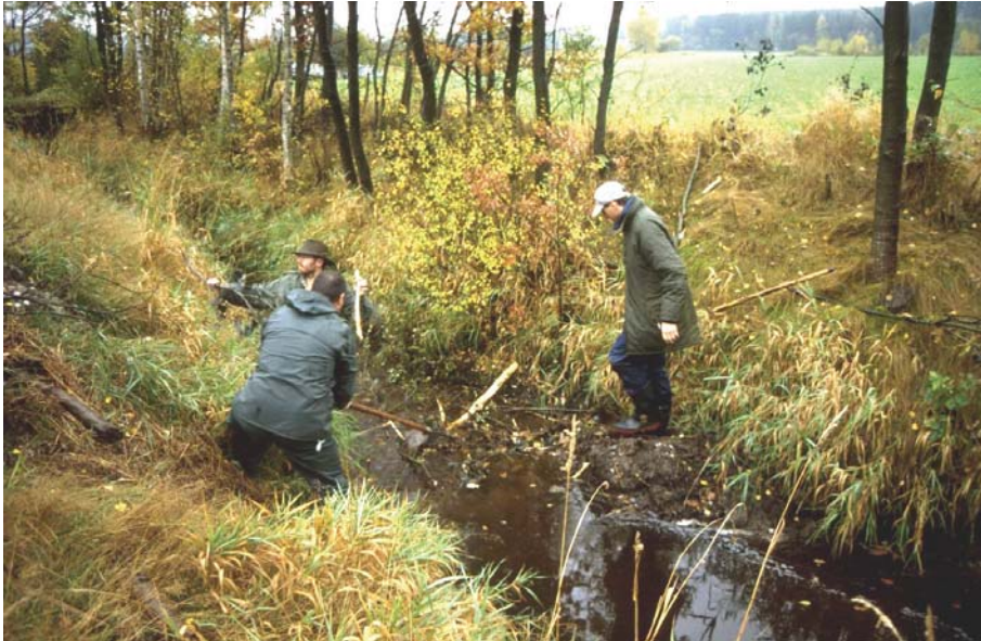
Abb. 6-6. Kleinere Biberdämme lassen sich von Hand meist schneller abtragen als mit einem Bagger.
