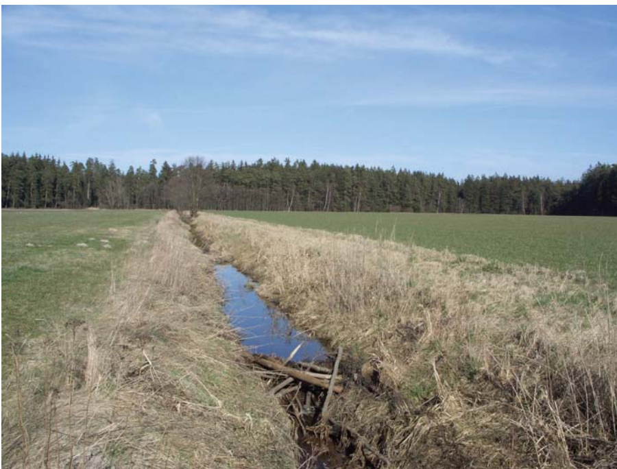
Abb. 5-14. Kleiner Damm, große Wirkung: durch den Rückstau laufen die die Flächen entwässernden Drainagen nicht mehr aus.
