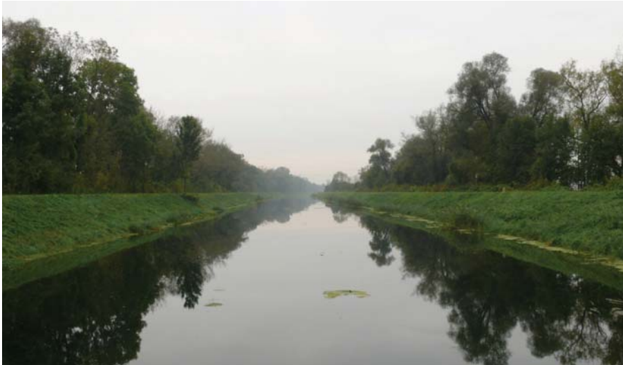
Abb. 17. Sempt-Flutkanal nördlich von München. Der Kanal wurde beidseitig durchgehend mit aufgelegtem 4-Eckgeflecht gegen Biber und Bisam gesichert. Am Ufer ist das Gitter bereits eingewachsen.
