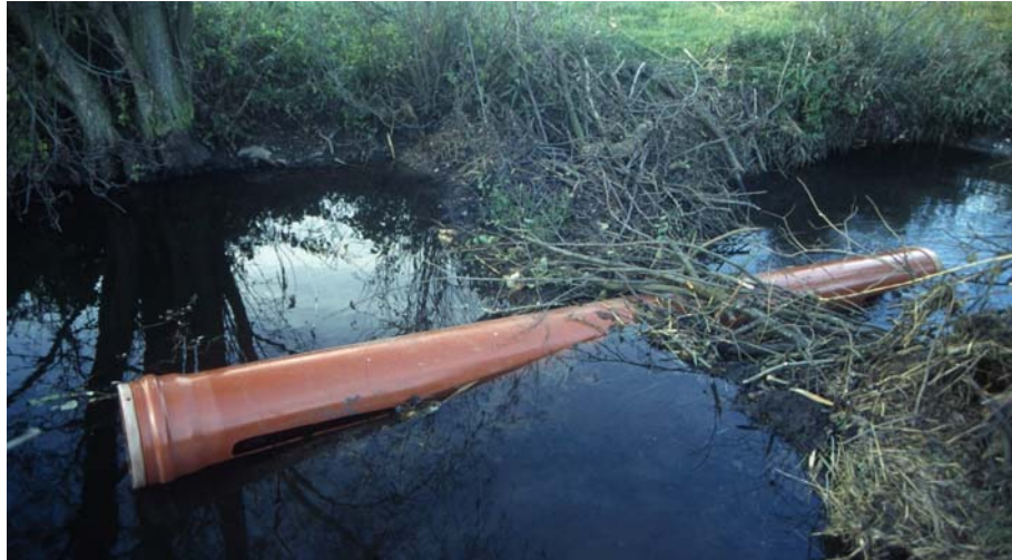
Abb. 2. Einfache Dammdrainage mit einem geschlitzten 400 mm KG-Rohr, noch ohne Sicherung des Einlaufs. Die Absenkung von ca. 30 cm ist am Baum zu erkennen.
