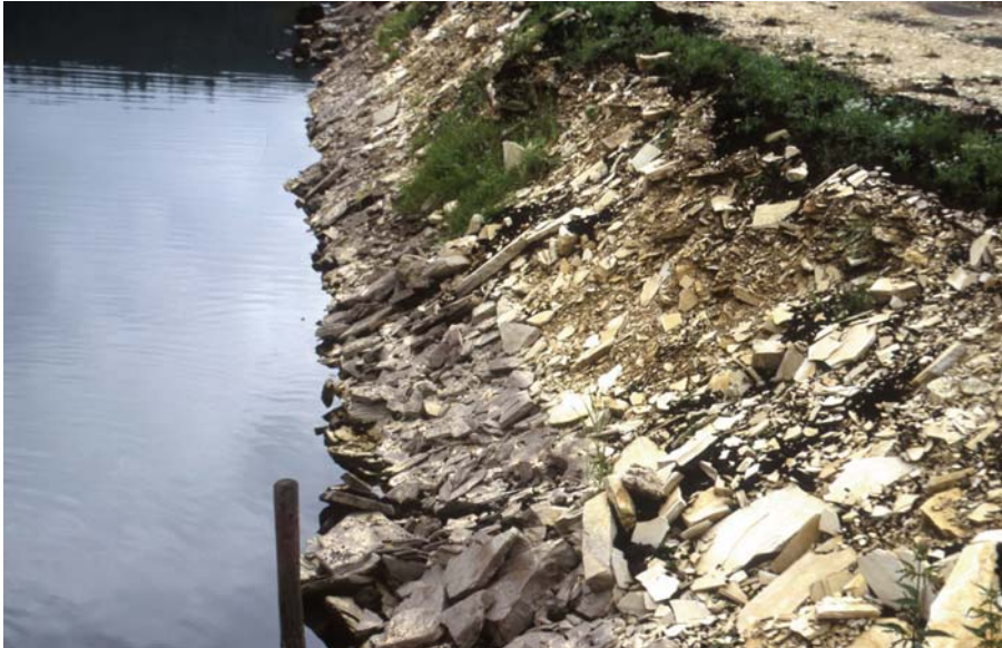
Abb.10. Breite Ufersicherung aus Bruchabfall an einer Teichanlage, gleichzeitig Unterbau für Wege.
