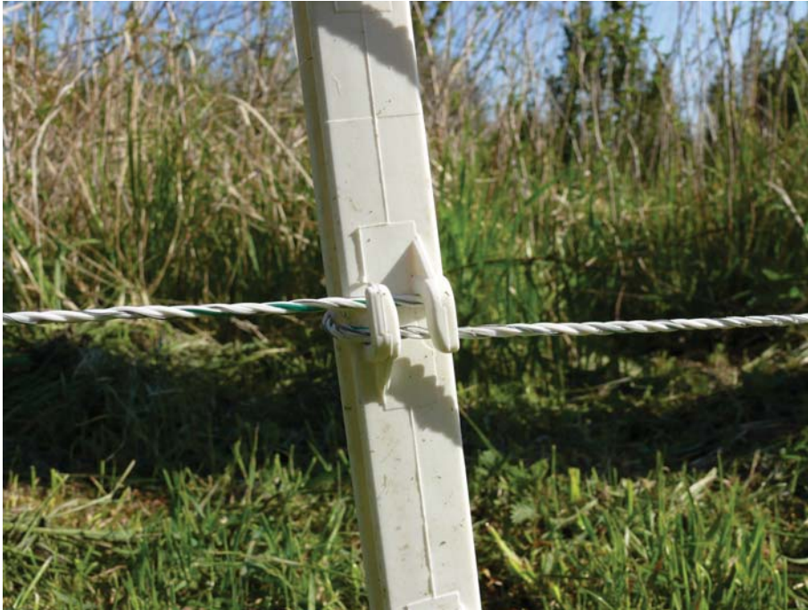
Abb. 4. Umwicklung des Pfahles zur Straffung der Litze.
