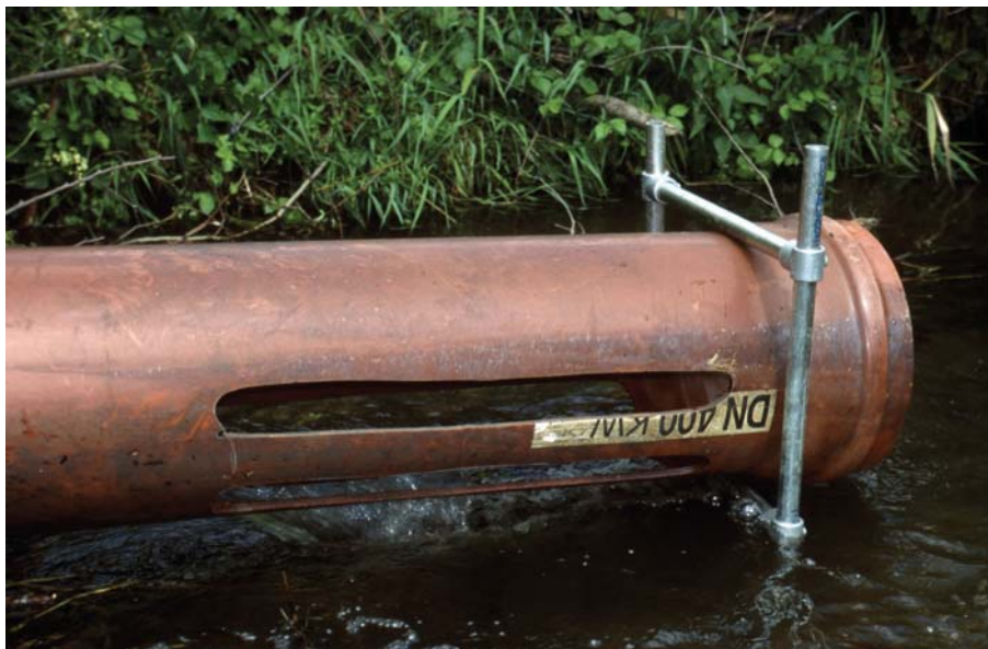
Abb. 4. Verstellbare Fixierung des Drainagerohrs.
