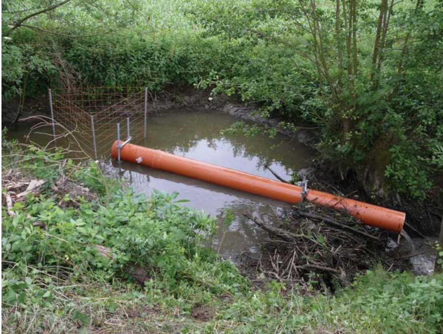
Abb. 7. Gesamtansicht einer Dammdrainage
