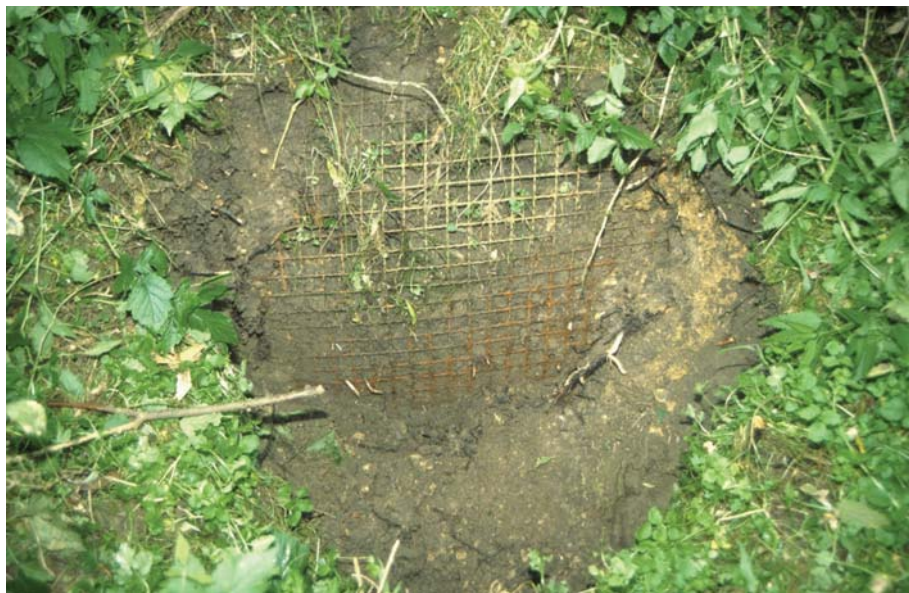
Abb. 3. Bibergitter an der kleinen Donau 18 Jahre nach dem Einbau.
