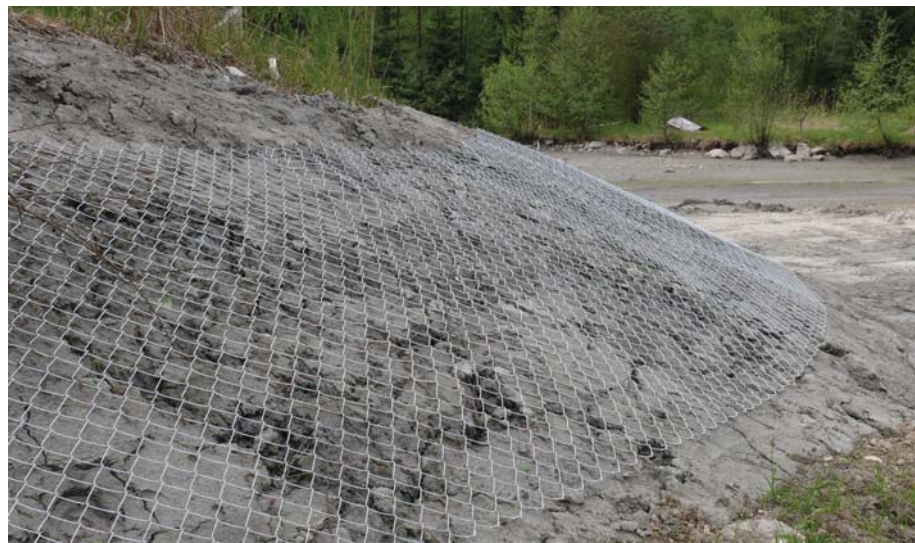
Abb. 15. Sicherung eines Teichdammes mit aufgelegtem 4-Eck-Geflecht.
