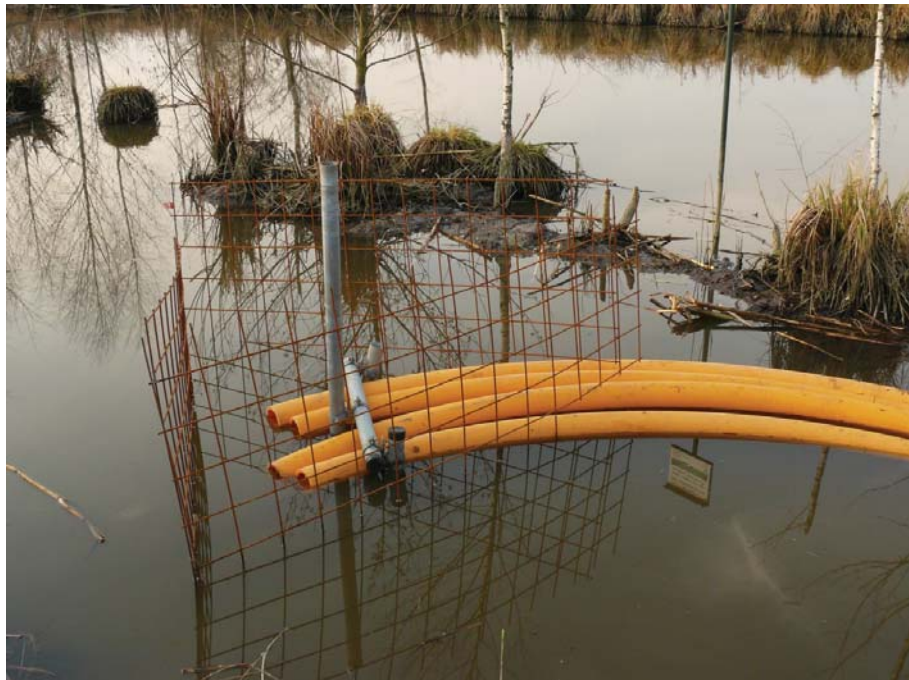
Abb. 3. Dammdrainage mit Drainagerohren und Sicherung des Einlaufes durch Baustahlgitter.
