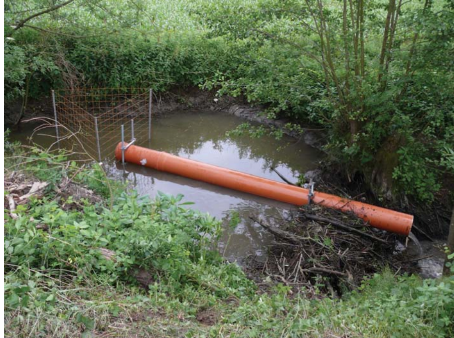
Abb. 6-7. Eine Dammdrainage (hier mit einem 40cm-Rohr) schafft einen Kompromiss zwischen von Biber benötigtem und vom Landnutzer duldbaren Wasserstand.
