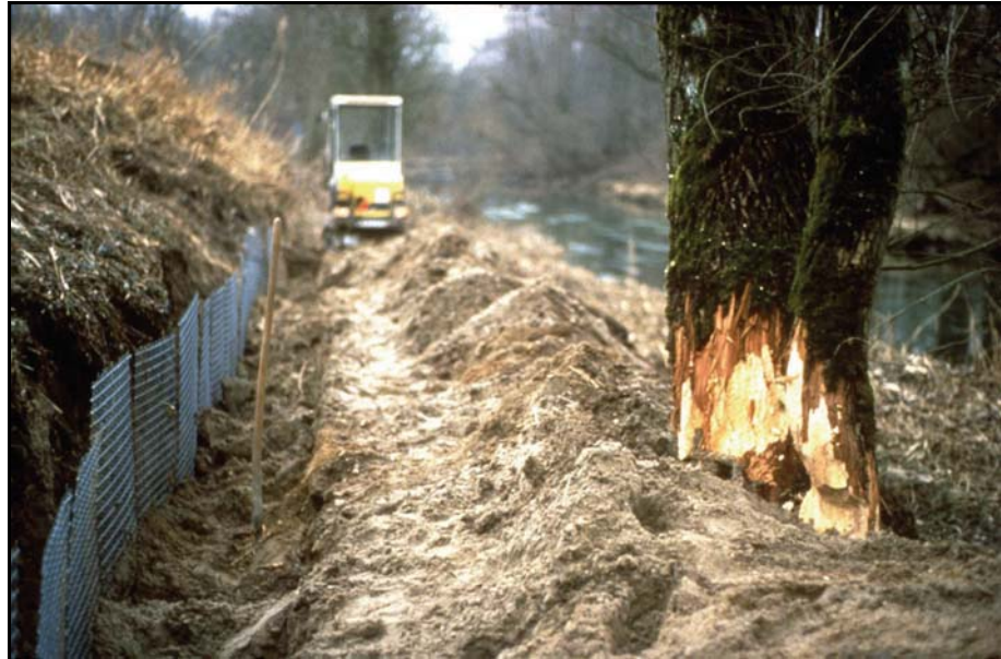
Abb. 2. Sicherung des Deiches der Kleinen Donau durch Gittereinbau (Foto: v. Lossow).
