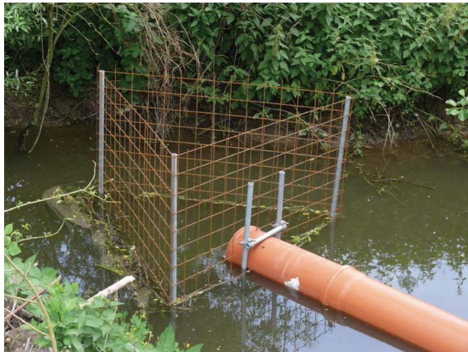
Abb. 6. Einlaufkorb aus Baustahlgitter.
