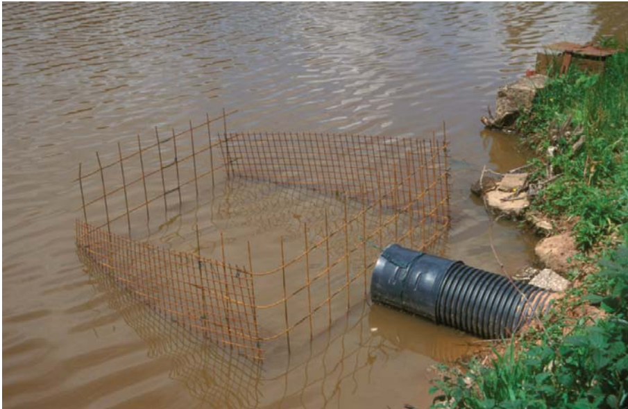
Abb. 6-9. Rohre und Durchlässe können mit Drahtgittern vor Bibern geschützt werden.
