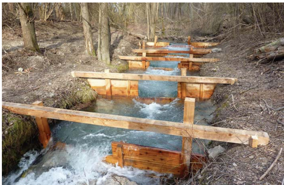
Abb. 12. Fischtreppe aus durchbrochenen Querriegeln als Aufstiegs- hilfe zum Biberdamm (oberhalb des letzten Querriegels) (Foto: M. Eder).
