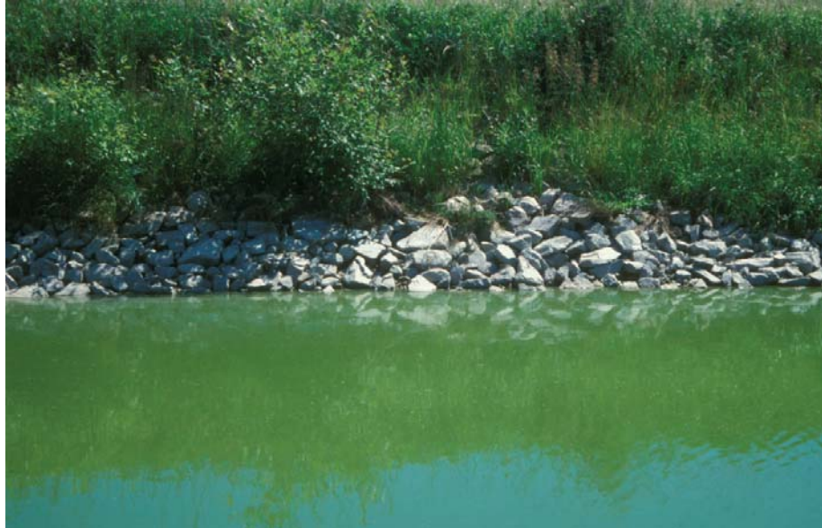
Abb.9. Ufersicherung mit mehreren Lagen Wasserbausteinen.
