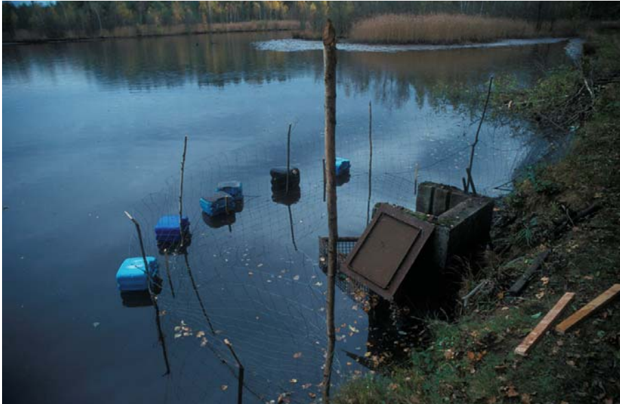
Abb. 4. Sicherung eines Teichmönches mit Kanisterkette.
