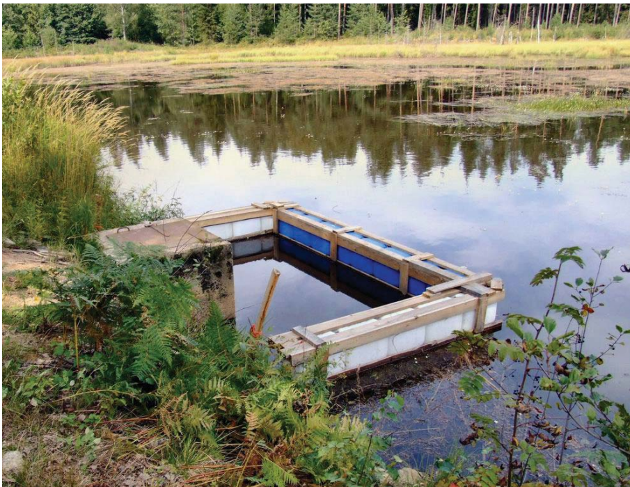
Abb. 5. Aufwendigere Sicherung eines Teichmönches mit verbundenen Kanistern.
