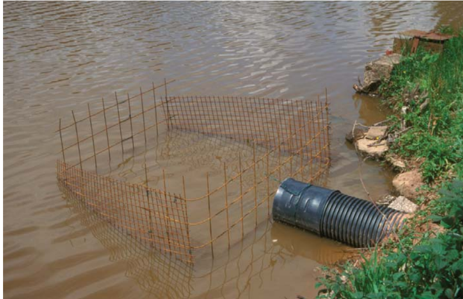
Abb. 2. Sicherung eines Überlaufrohres in einer Teichanlage mit einem Korb aus Baustahlgitter.
