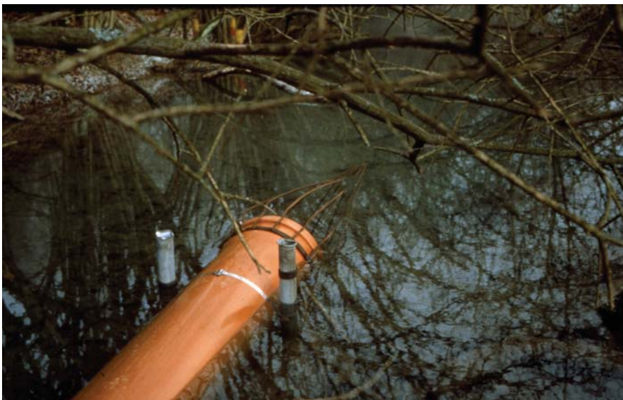
Abb. 8. Einlaufsicherung als „Haube“, feste Fixierung des Rohres mit Eisenband an den Trägern..
