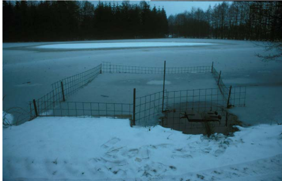
Abb. 6. Sicherung eines Teichmönches mit Baustahlgitter
