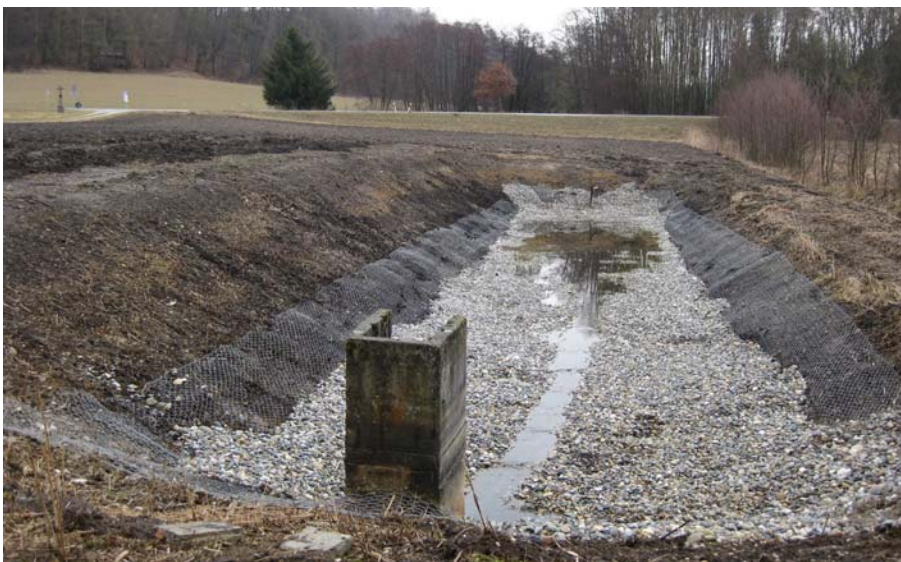
Abb. 14. Sicherung eines Teiches in Schwaben mit aufgelegten Gitternetzen. Die zusätzliche Kiesschüttung dient der Stabilisierung des Teichsohle (Foto: Schmid).
