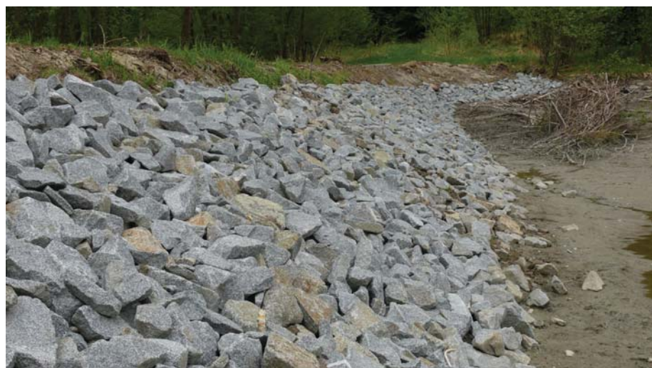
Abb. 16. Überdeckung des Gitters aus Abb. 15. mit zweilagiger Steinschüttung. Die Steinschüttung war zur Sicherung des Ufers gegen Wellenschlag notwendig.
