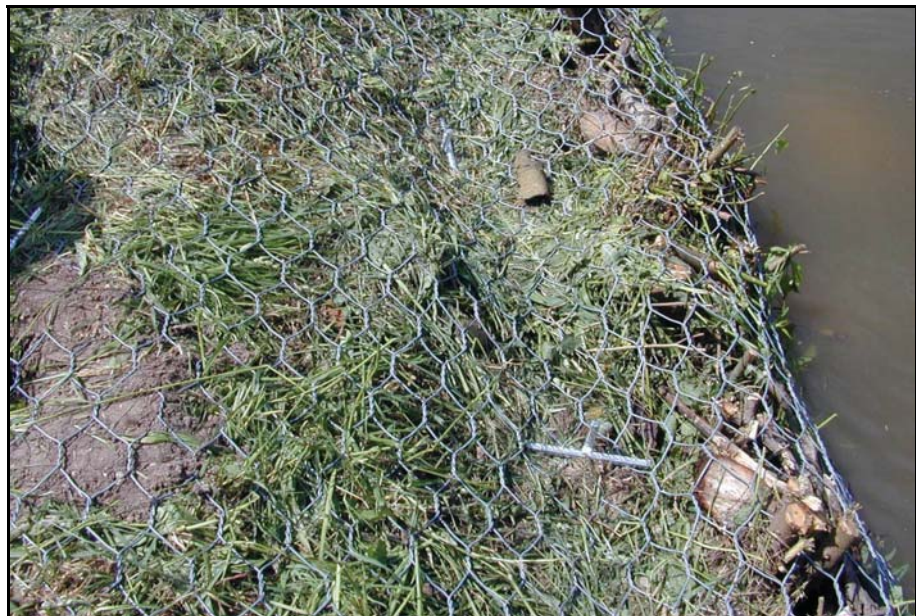
Abb. 12. Ufersicherung durch aufgelegtes Steinschlagschutznetz (Foto: Traub).
