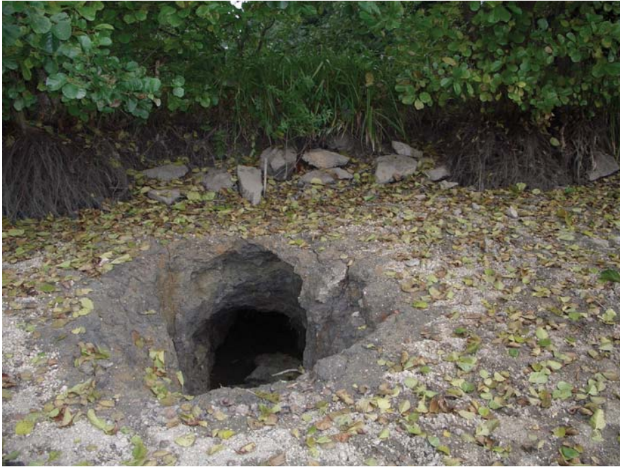
Abb. 13. Biberröhre in einem Teichdamm.
