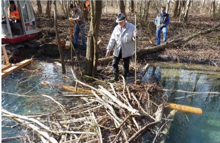
Abb. 11. Drainagerohr im Biberdamm als Fischdurchlass (Foto: M. Eder)
